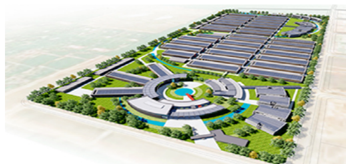
Nhà máy LONGWELL - KCN Dầu Giây
