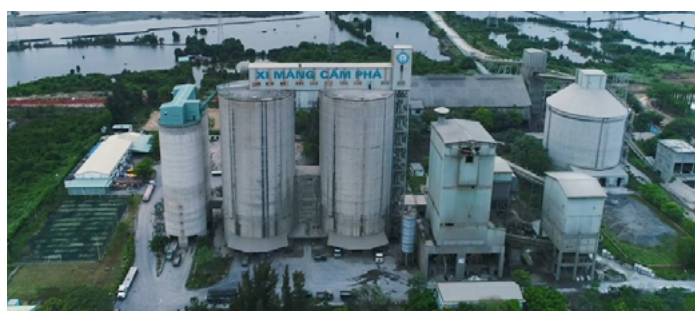
Nhà Máy Xi Măng Cẩm Phả
