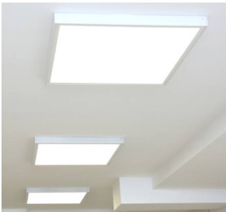
Lắp đặt ốp nổi
