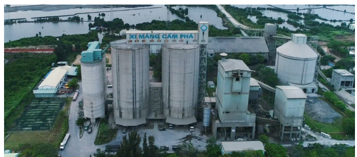
Nhà Máy Xi Măng Cẩm Phả
