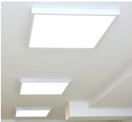
Lắp đặt ốp nổi
